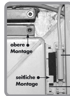
Melder- Halter Befestigung an dem Fensterahmen Magnet- Halter Befestigung an das Fenster
